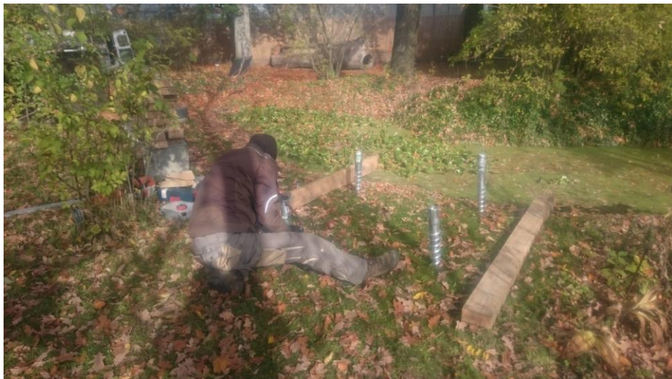
Instalace zemních vrtů
